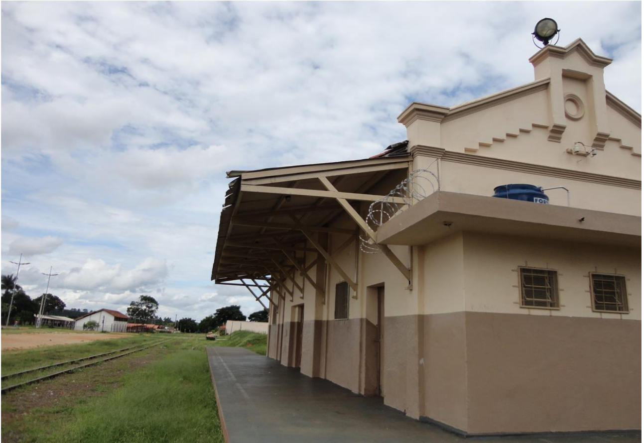
Estação Ferroviária de Buri, localizada no quilômetro 291 da Estrada de Ferro da Sorocaba. Na imagem é possível ver um dos faróis do Trem Blindado, ou seja, no topo da Estação. Foto. Portal Paulistas de Itapetininga (2019).
