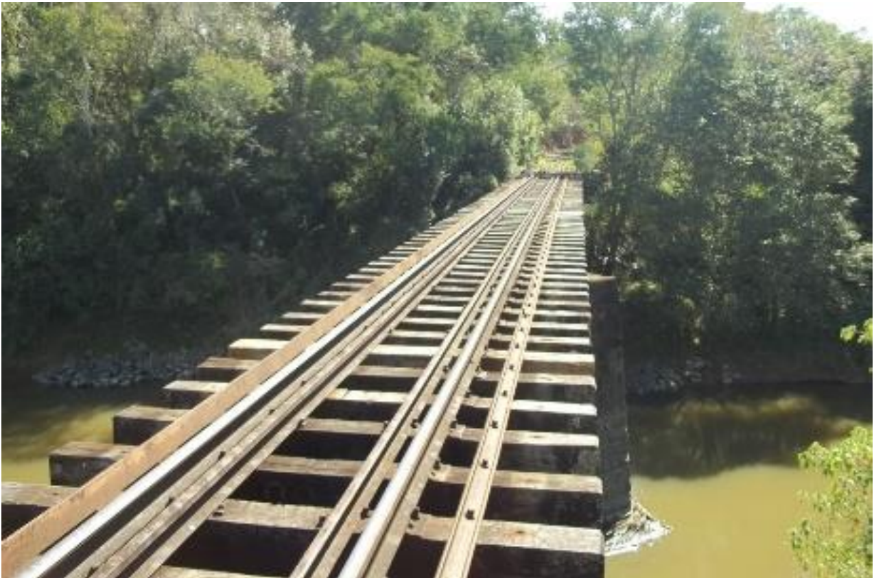
A ponte sobre o Rio Paranapanema próxima à Estação Ligiana.
