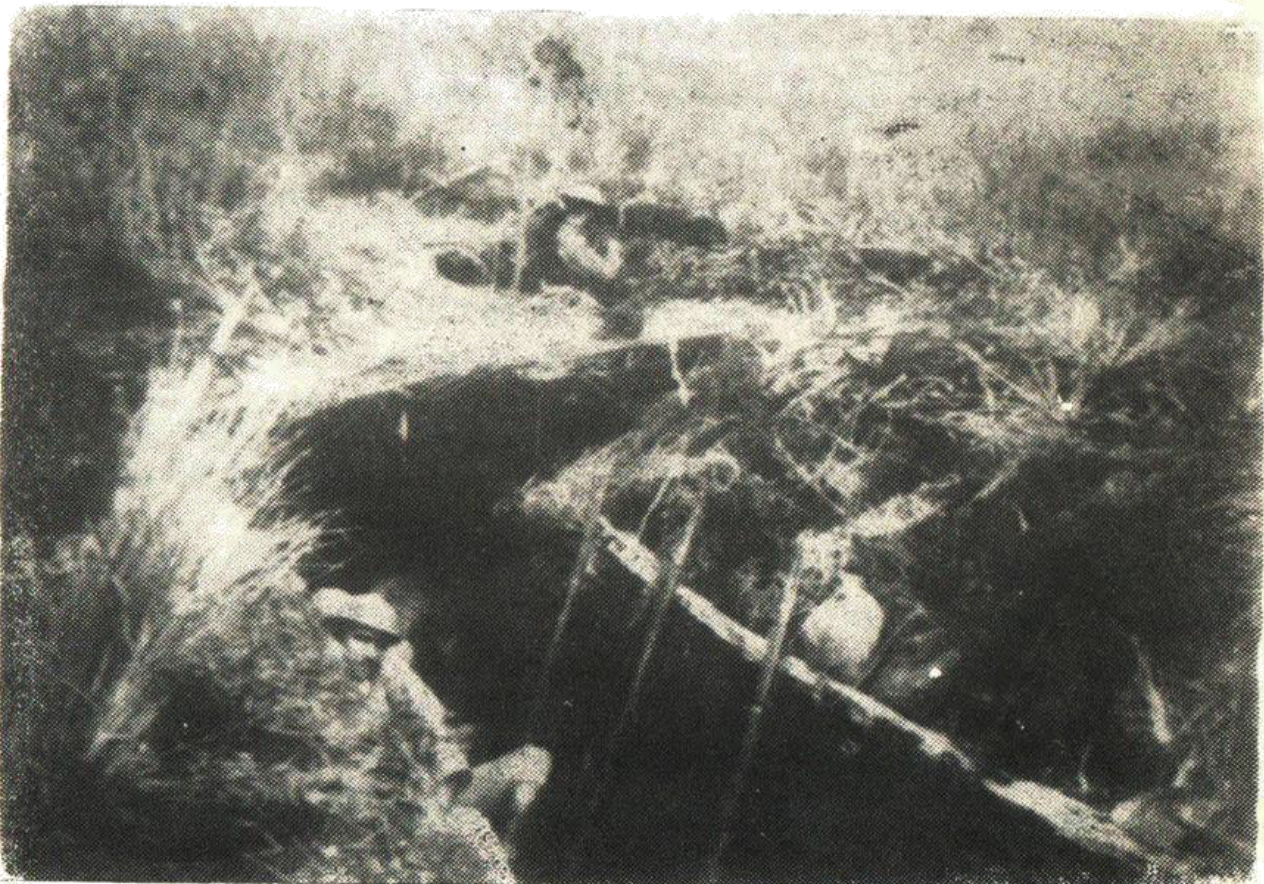
Trincheira do 14 de Julho no Cerrado
